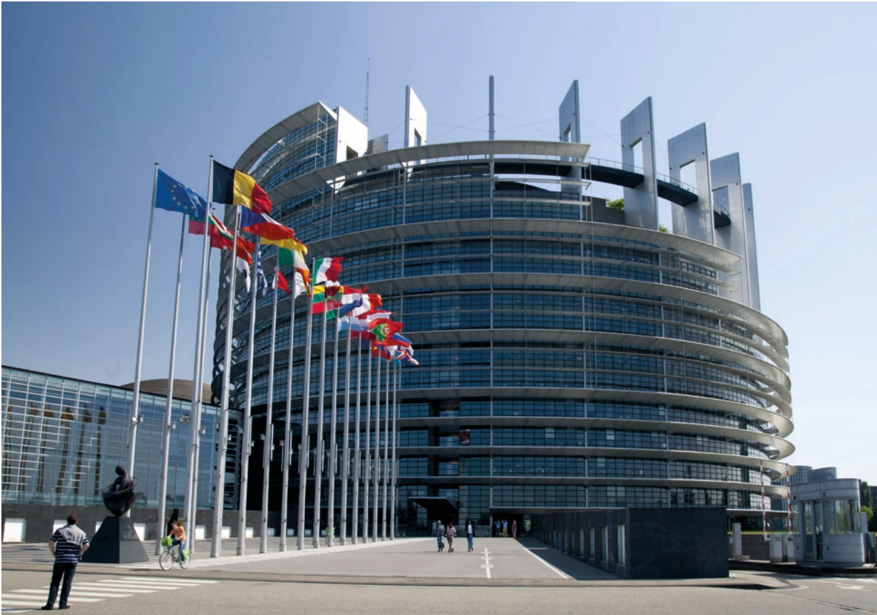
Das Gebäude des Europäischen Parlaments auf diesem Bild ist in Frankreich in der Stadt Straßburg.
