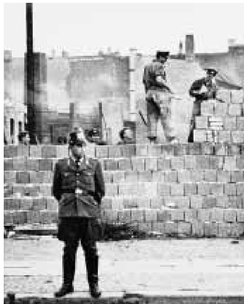
Die Mauer wächst. Ostberliner Bauarbeiter setzen einen Ziegel auf den anderen.
