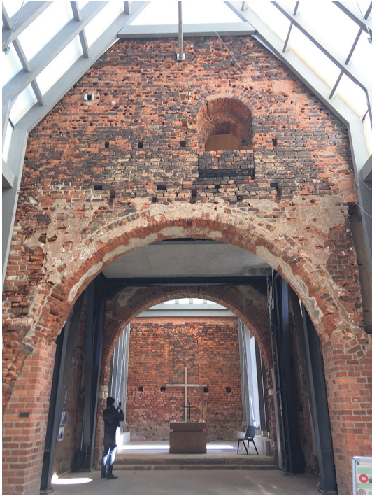
Rettung und Weiterbau einer Kirchenruine zur Fahrradkirche in Markkleeberg-Zöbiger.
