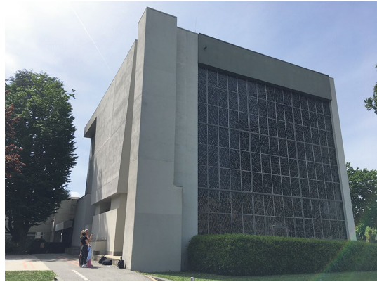
Dornbusch-Kirche Frankfurt am Main; Rückbau des Kirchenraums und Gewinnung eines Kirch-/Spiel-Platzes
