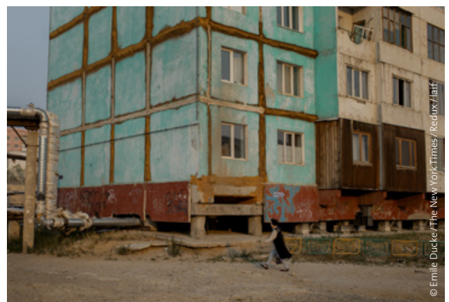
Stelzenhäuser, wie hier in der Stadt Jakutsk, verlieren durch den auftauenden Permafrostboden ihre Stabilität und werden auf Dauer unbewohnbar.
