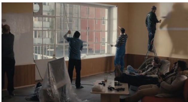
Renovierung des Gemeinschaftsraums
