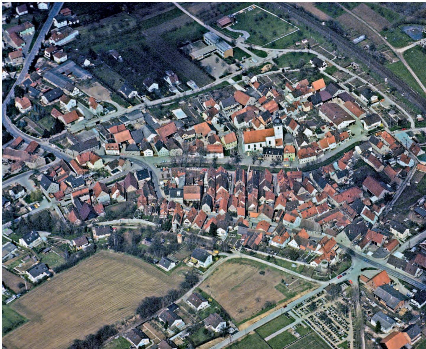
Das Dorf ist die in Deutschland häufigste Siedlungsform. Ein mittelgroßes Beispiel ist Goßmannsdorf in Unterfranken, eng bebaut und ehemals befestigt mit derzeit etwa 1050 Einwohnern.
