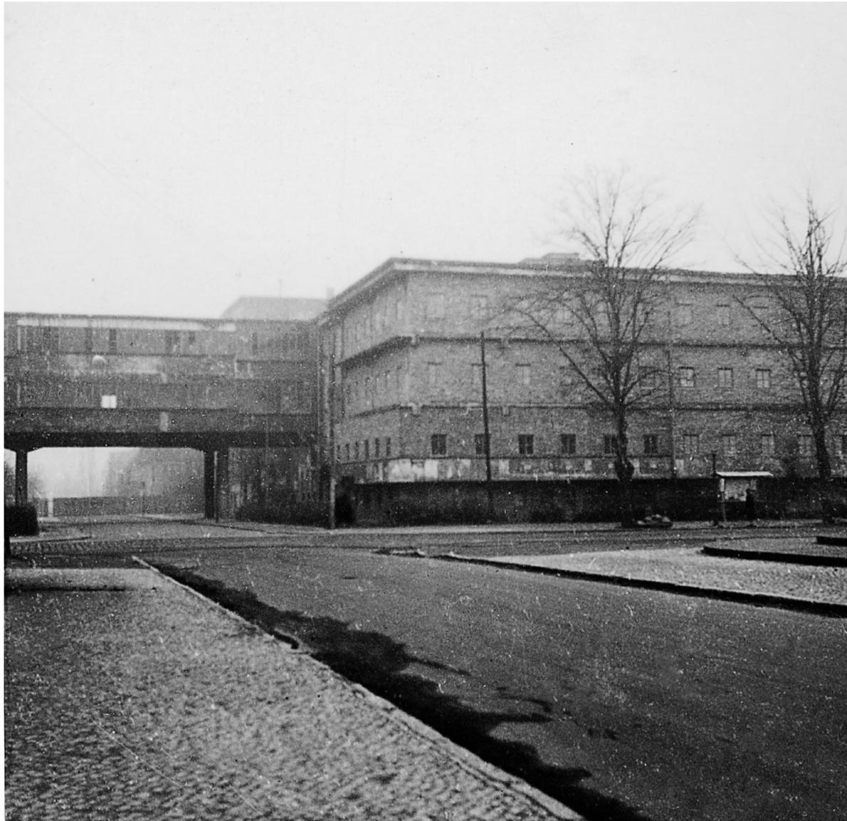
Bauhausgebäude nach den ersten Reparaturmaßnahmen mit Ausmauerung der Fassade Werkstattflügel im Winter 1945
