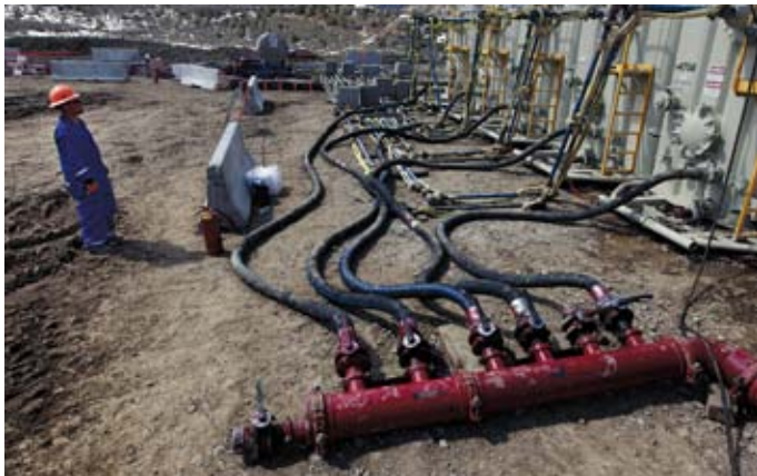
Die Gewinnung von Schiefergas mittels Fracking führt zu niedrigen Energiepreisen in den USA. Ein Arbeiter kontrolliert die Einschleusung des Druckwassers während eines Fracking-Prozesses bei Rifle, Colorado, März 2013.
