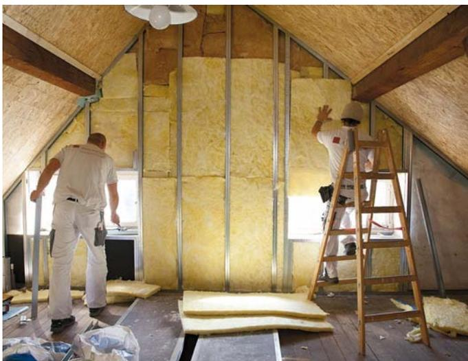
Erfolgsfaktor Energieeffizienz: Eine fachgerechte Wärmedämmung reduziert den Heizbedarf und spart Energiekosten.
