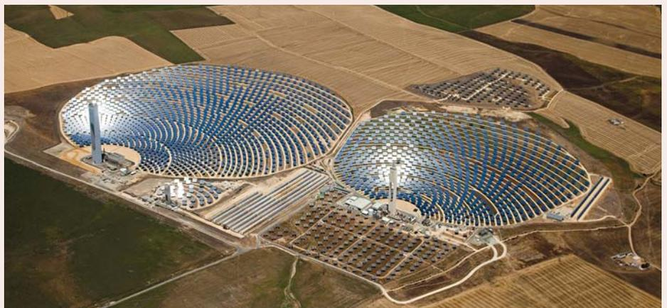
Solúcar nahe Sevilla (Südspanien) ist der größte Solarkomplex europaweit. Die beiden Turmkraftwerke sowie die Solarrinnenanlagen liefern Strom für nahezu 94 000 Haushalte und produzieren zurzeit 183 MW.
