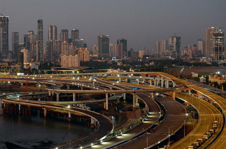
Baustelle für Mumbais Küstenstraßenprojekt, 21. Februar 2024. Die neue achtspurige Schnellstraße an der Küstenlinie Mumbais soll die Fahrtzeit zwischen den südlichen und den nördlichen Teilen der Millionenstadt verkürzen
