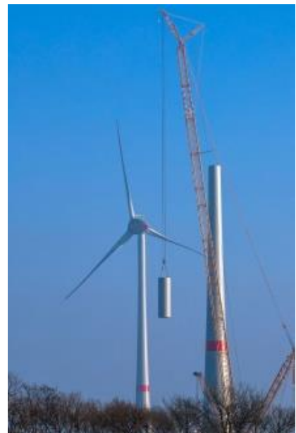
Ein neues Windrad wird gebaut (© picture-alliance/dpa)
