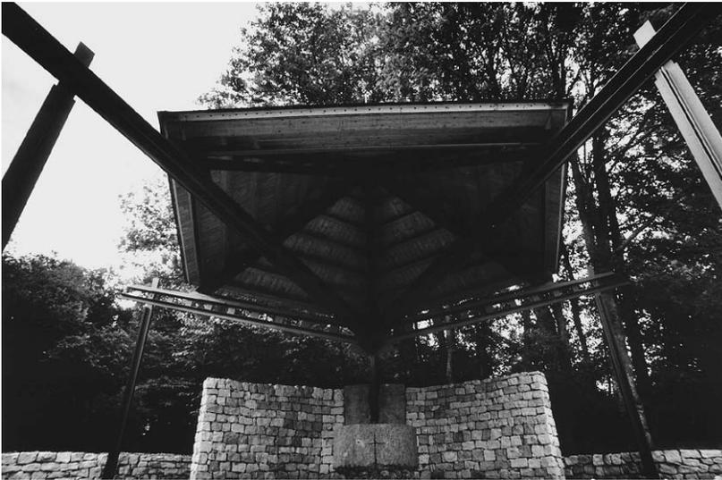
Gedenkanlage Grafeneck, errichtet im Jahre 1990 als offene Kapelle. Das Dach wird von fünf Stahlstützen getragen, Symbol für das fünfte Gebot »Du sollst nicht töten«.
