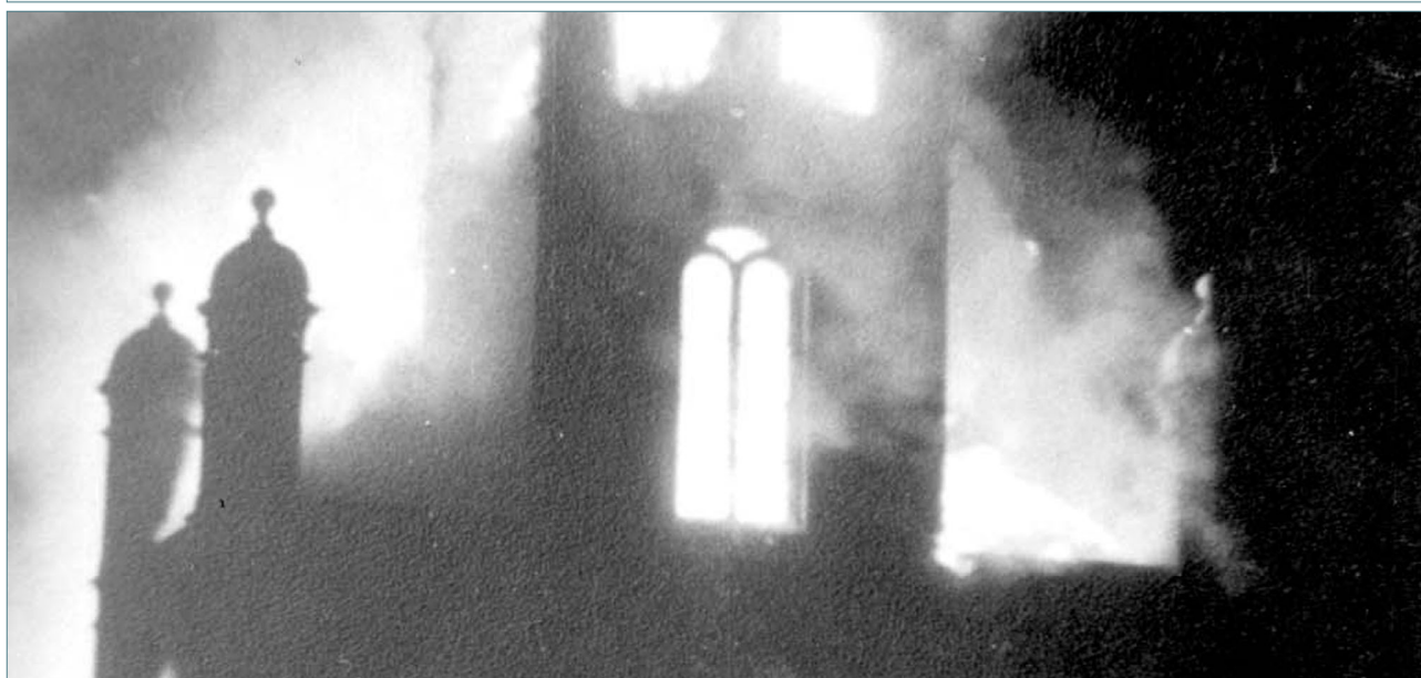
Die brennende Synagoge von Groß-Gerau (9. November 1938).
